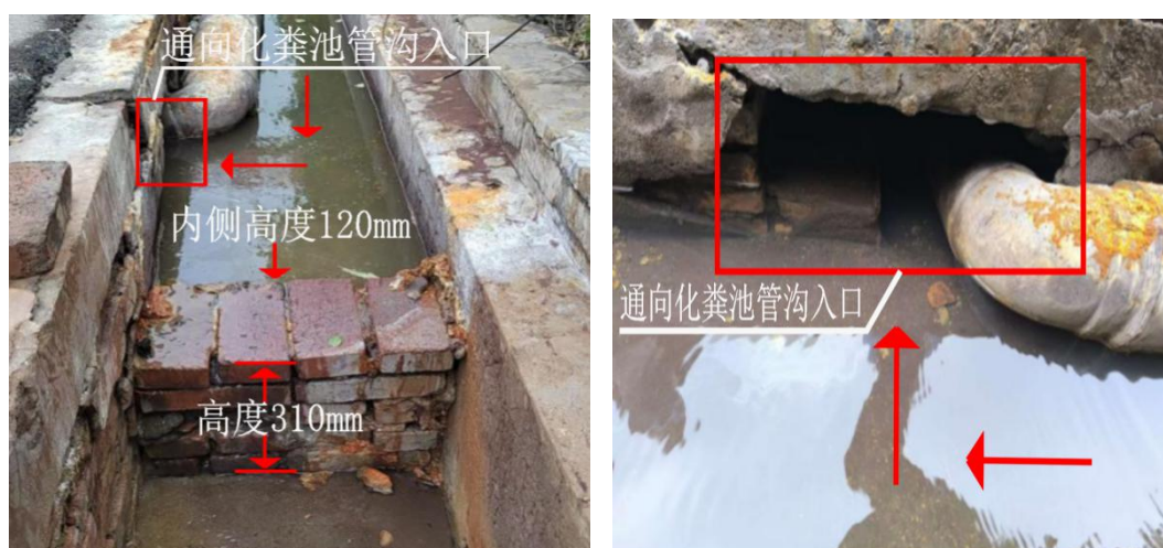
图 5 雨水总渠沉淀隔墙及通向化粪池水沟现状
