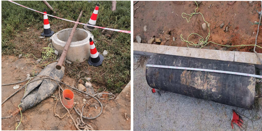
图4 未充气的黑色堵水气囊、充气的管道修复气囊现场照片
